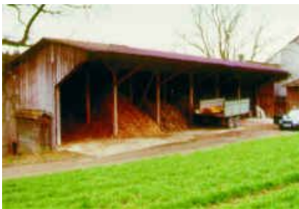
Abb. 27: Mit Hackschnitzeln befüllte Lagerhalle
